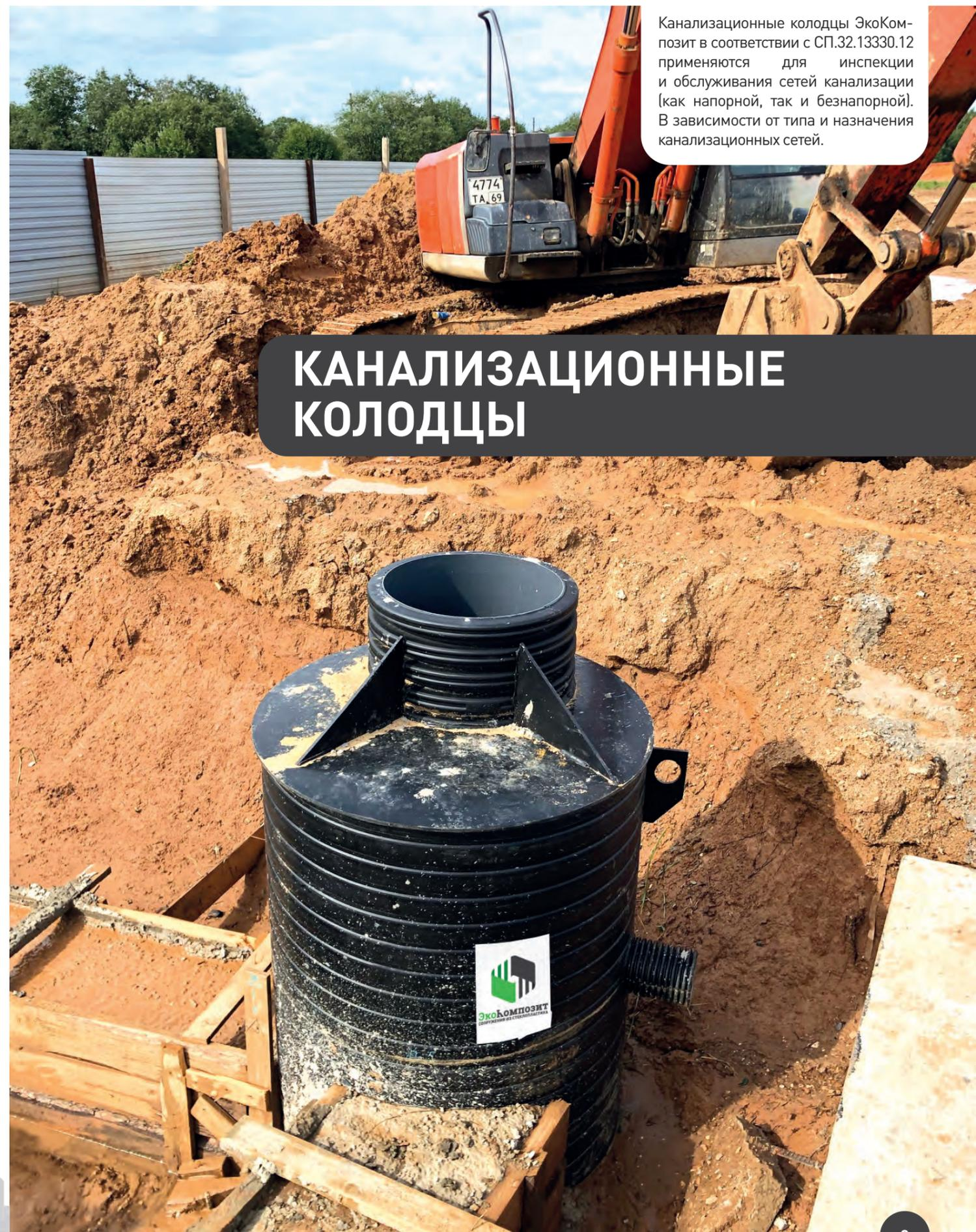
Канализационные колодцы ЭкоКомпозит в соответствии с СП.32.13330.12 применяются для инспекции и обслуживания сетей канализации (как напорной, так и безнапорной). В зависимости от типа и назначения канализационных сетей.
